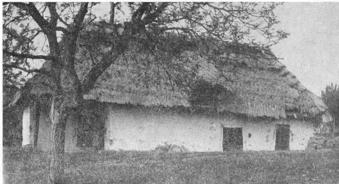
Vinohradnícka stavba s lisovňou, pivnicou a maštaľou z 19. storočia. Sebechleby. Foto E. Kahounová 1965. NÚ SAV
